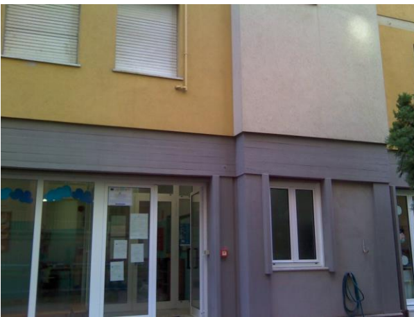
Figura 5: Muratura esterna Nord
