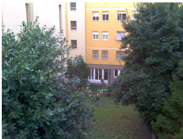
Figura 1: Muratura esterna Nord
