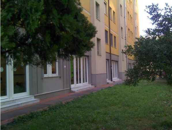
Figura 3: Muratura esterna Nord
